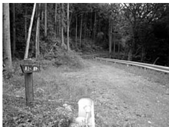
森林管理道新設改良事業の栗野山線の現状
