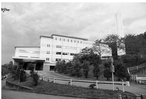
改修が予定されているクリーンセンター
