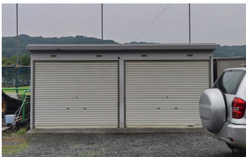
図 5-10 現状のトイレ横の倉庫
