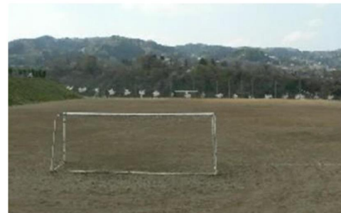
影森グラウンド（多目的グラウンド） 人工芝化に向けて工事に着手
