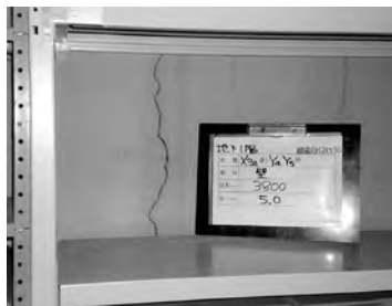
本庁舎のクラック(ひび割れ)
