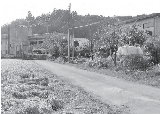
学童の通行に支障をきたしている市道大田539号線
