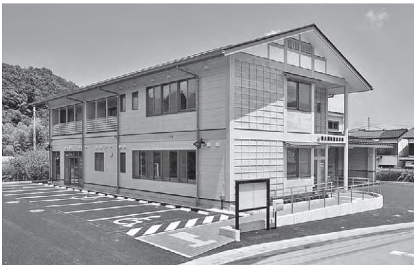
公共建築物の木質化の事例「秩父消防署東分署」
