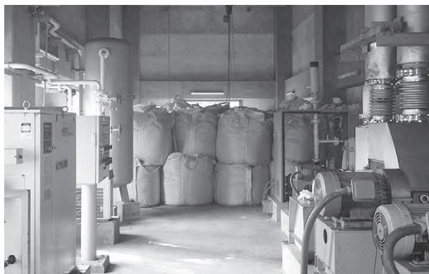
保管してある焼却汚泥
