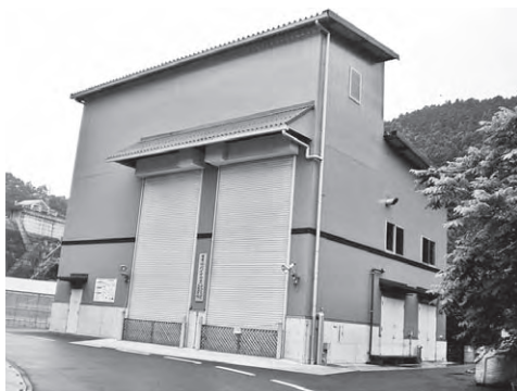
脱原発に向けて国が進める自然エネルギー施設 秩父市元気村「バイオマス発電所」
