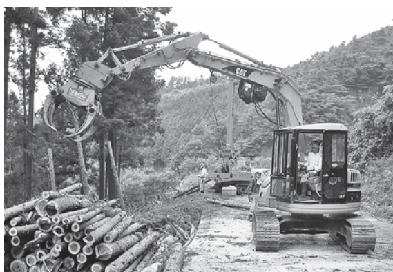
利用間伐作業の様子
