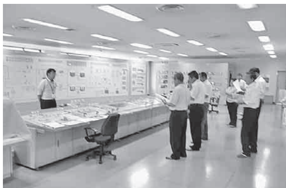
下水道センターの現地調査の様子
