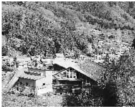
吉田元気村に完成したちちぶバイオマス元気村発電所（写真手前左の建物）
