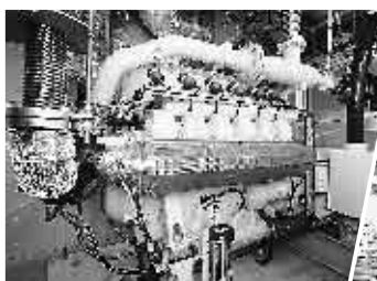
▲ガスエンジン
