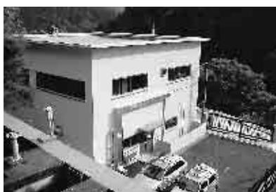
っていましたが、新規許可水量として吉田川支流の小川川からも日量828m<sup>3</sup>を確保し、取水堰とポンプ室を築造して、塚越浄水場の合計許可水量を日量2,588m<sup>3</sup>にアップしました。ろ過施設も高度浄水処理施設に全面改修整備され、将来に向けて安全で良質な水の安定供給を構築することができました。
