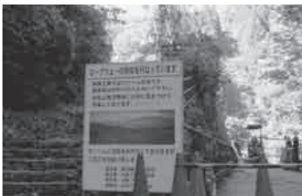
東洋一と言われた三峰ロープウェイの撤去解体
