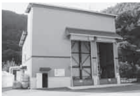
吉田元気村バイオマス発電所
