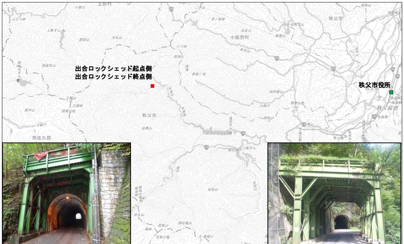
出合ロックシェッド起点側（中津川） （秩父市中津川字後山 562-1）
