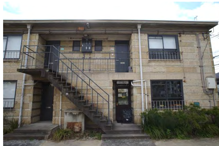
壁面と調和した屋外階段とした例
