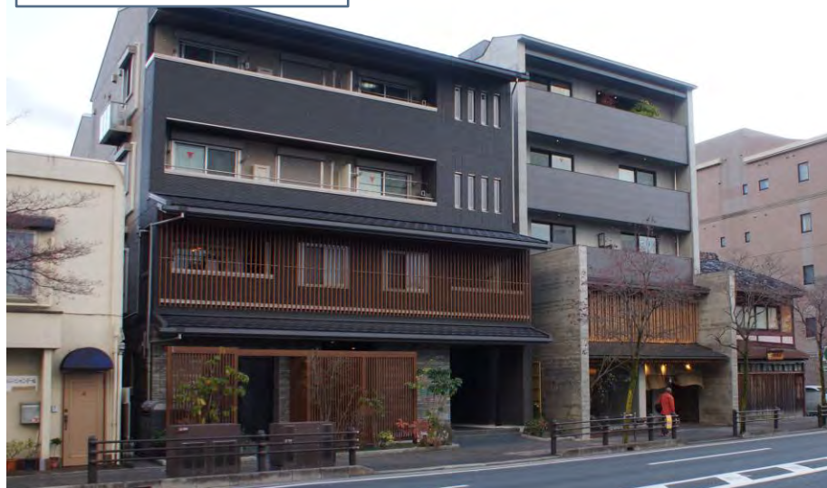
軒庇の設置、縦格子
