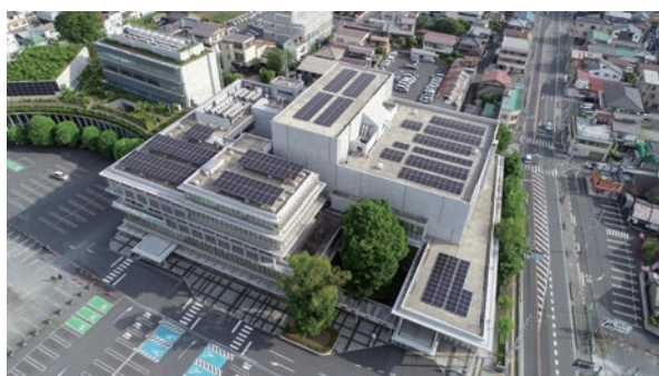
本庁舎・市民会館に設置された太陽光パネル
