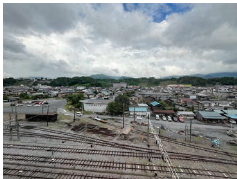
将来のまちづくりの中核部として地籍調査の実施が待たれる秩父駅東口付近
