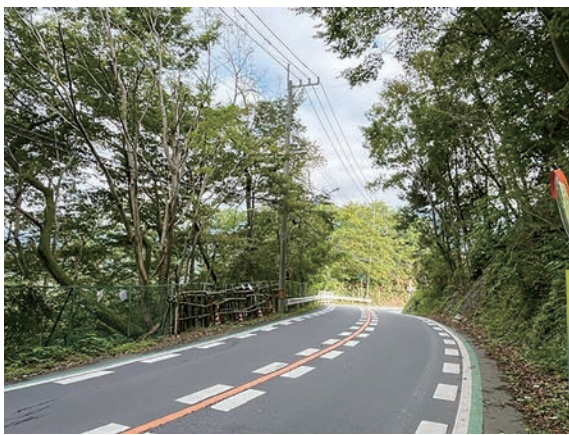
安全対策が望まれる県道72号
