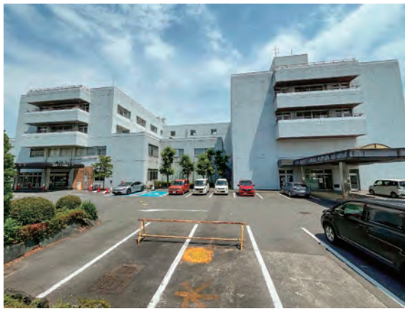
老朽化が進む市立病院の南館(右、築44年)と本館(左、同34年)
