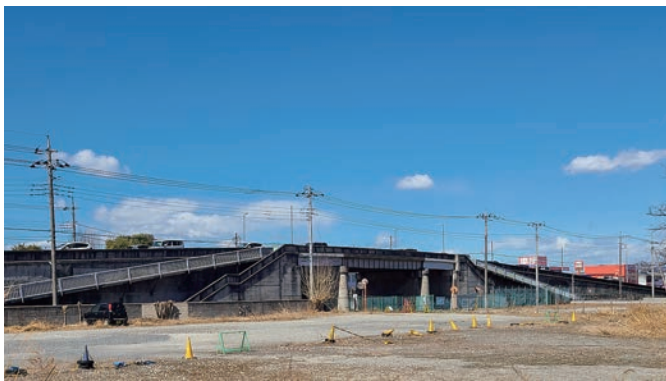
平面化が予定されている秩父陸橋
