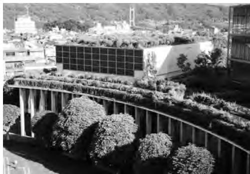
歴史文化伝承館の太陽光発電設備
