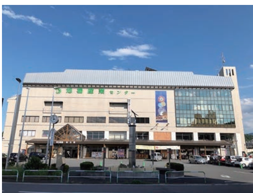
完成から38年が経過した地場産業センタービル
