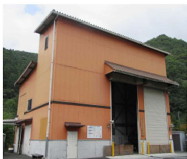
ちちぶバイオマス元気村発電所
