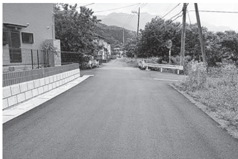
整備の進む荒川幹線2号線
