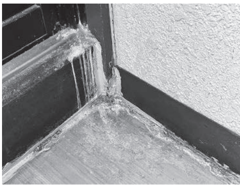
長寿命化への遠い道(築41年で早老化する保健センターの床)
