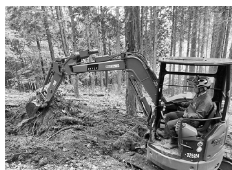
バックホーで根株を取り除く
