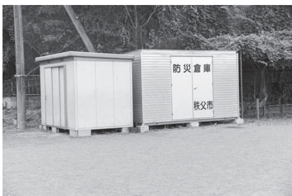
学校敷地内に設置の防災倉庫
