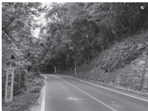
県道72号秩父荒川線 (久那地内)
