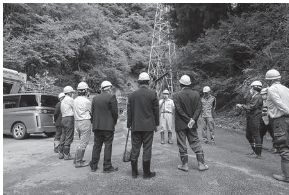
大滝温泉源泉掘削工事の現地調査
