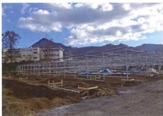
「産地パワーアップ事業」施設 (令和7年11月建設中)
