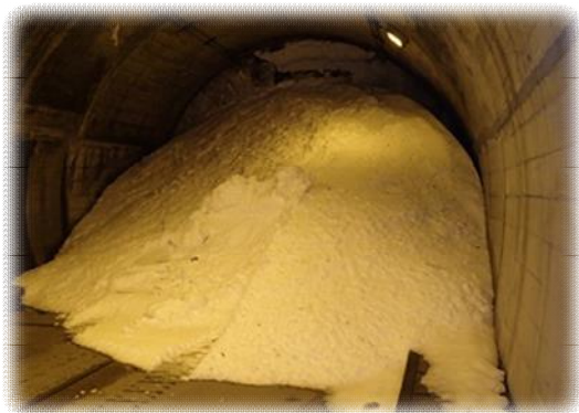
【写真】大滝地区トンネル
