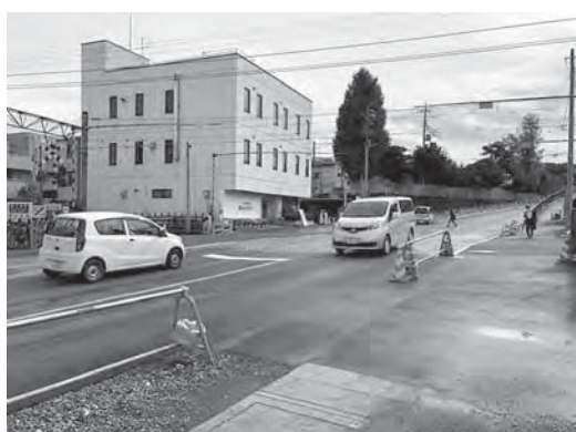
指摘されている踏切付近
