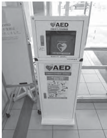
設置されているAED（市役所入口）
