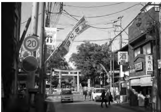
周辺整備が望まれる番場通り
