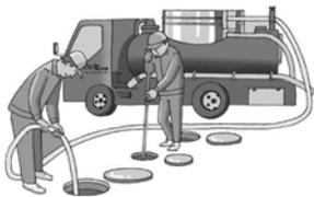
浄化槽の中には微生物が分解できないものや微生物の死骸が汚泥となって溜まります。溜まった汚泥は引抜きし、内部の装置を洗浄しなければ本来の効果を発揮せず、故障の原因にもなってしまいます。
