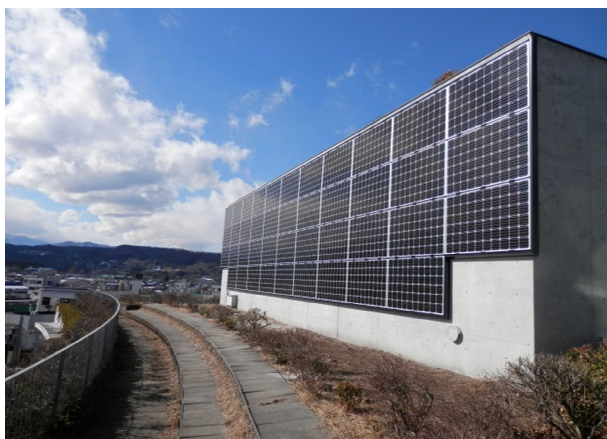
秩父市歴史文化伝承館壁面の太陽光パネル
