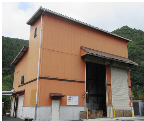
ちちぶバイオマス元気村発電所
