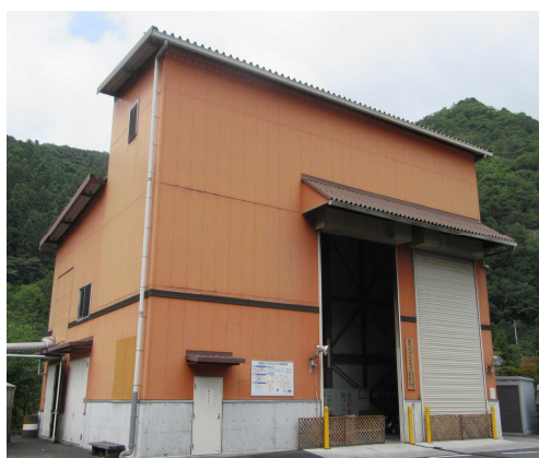
ちちぶバイオマス元気村発電所
