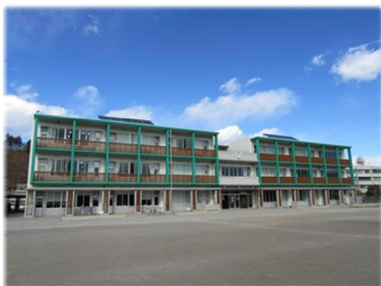
秩父市立尾田蒔小学校の太陽光発電
