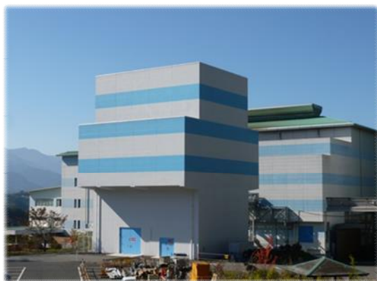
秩父市クリーンセンターごみ焼却発電
