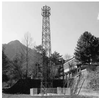
中津川携帯電話用鉄塔
