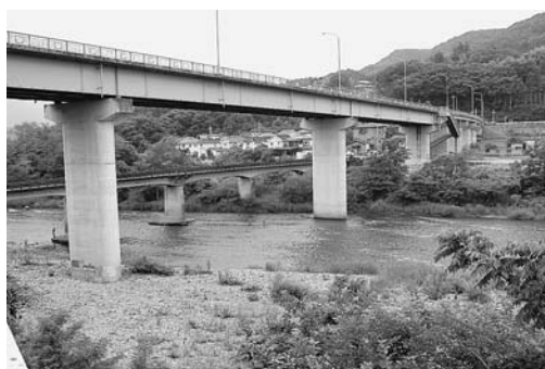
岩盤化が進んでいる佐久良橋付近
