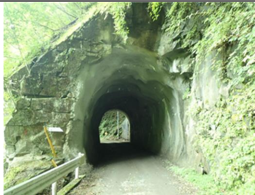
1号トンネル(中津川)
