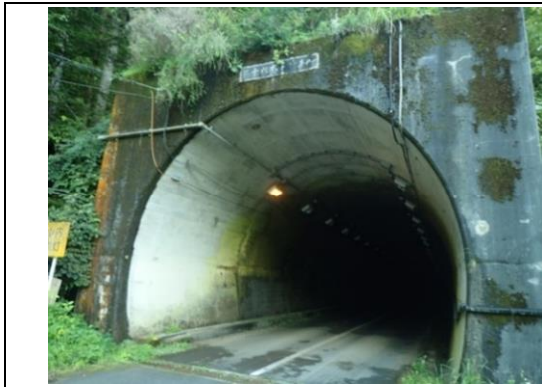
二十六木トンネル(荒川)
