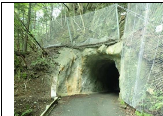
鞍掛隧道(荒川日野)
