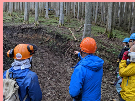
(参考) 岡橋氏による作業道開設指導の様子 (大滝栃本市有林にて)
