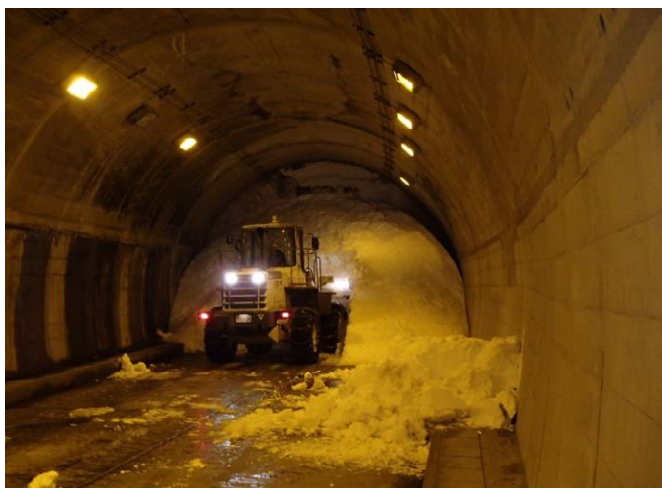
トンネル内に侵入した雪 (2014(平成 26)年:大滝・中津川)
