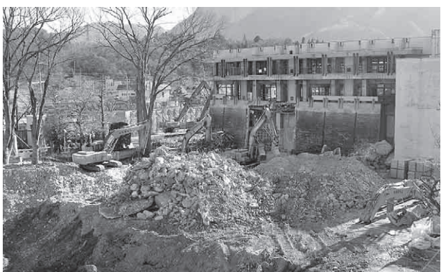
解体が進む市役所本庁舎および市民会館
