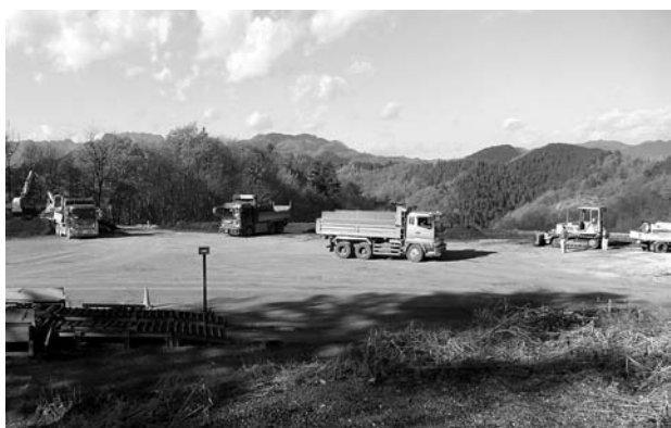
大量の土砂が搬入されている柳久保の現場
