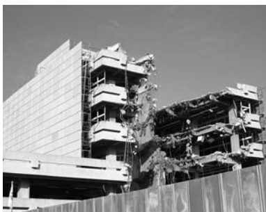
市役所本庁舎解体の様子 (10月中旬撮影)
