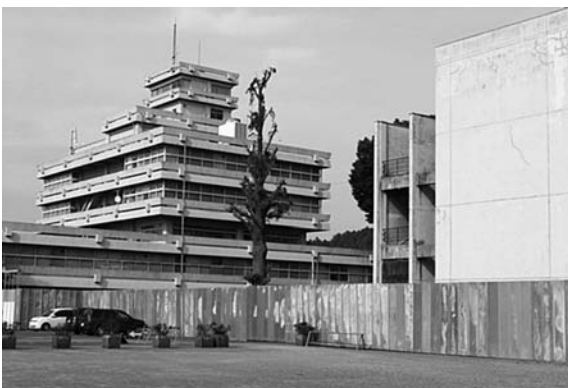
解体準備が始まった市役所・市民会館
