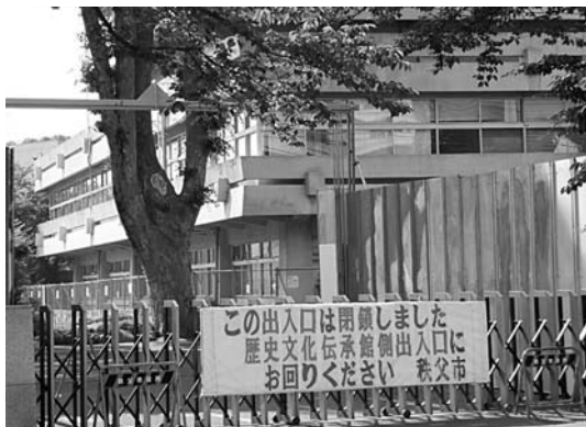
取り壊しを控えた本庁舎・市民会館
