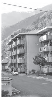
白久の市営住宅
