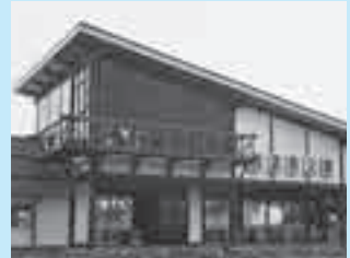
完成間近の西武秩父駅
