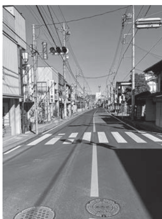
整備が待たれる3・4・5号中央通線 (上町2丁目付近)
