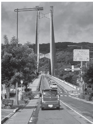
渋滞解消が望まれる公園橋通り
